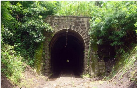
EL TÚNEL FERROVIARIO DE CAMBALACHE
